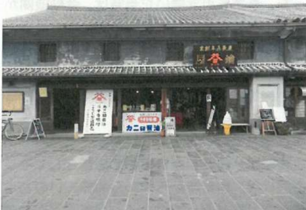
改装した店舗
